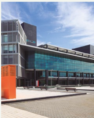
Andalusia Technology Park. Kontor med hög energieffektivitet. Spanien. ECOi
