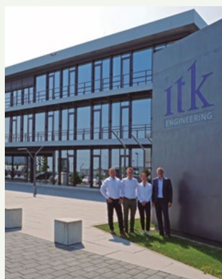
ITK Engineering GmbH. En innovativ kontorsbyggnad i Tyskland. ECOi - PACi
