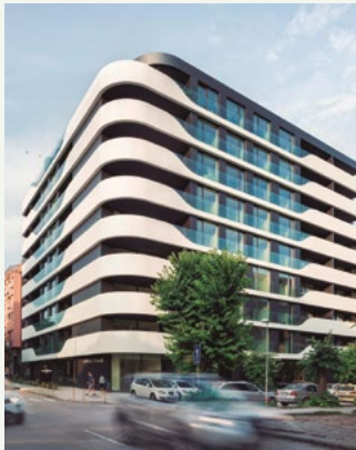
Bostadshus i Bulgarien - med effektiv HVAC-lösning. Aquarea
